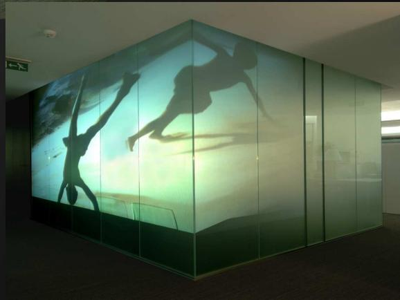
1. Vitrage feuilleté à transparence contrôlable, tel le Priva-Lite, qui enferme un film de cristaux liquides (LC) qui le rend opalin et qui, sous l'influence d'un courant électrique, devient transparent. Ce qui permet alors de l'utiliser comme support de rétroprojection.
